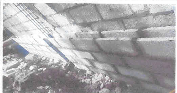
Foto 2: Ampliacion de paredes de block para cocina
