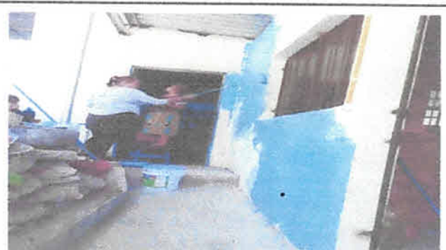
Foto 4: Aplicacion de pinutra en areas interiores y exteriores de la Escuela
