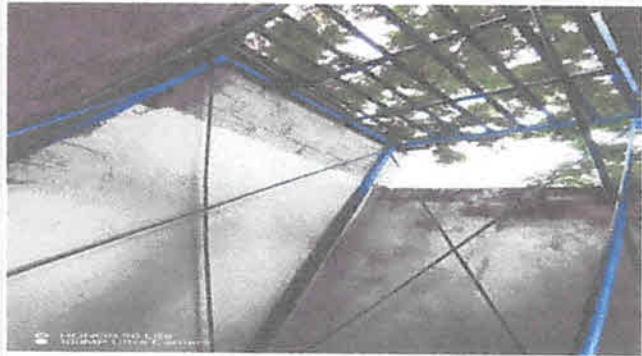
Foto 1: suministro e inslacion de estructura metalica y rotoplas para distribucion de agua en sanitarios
